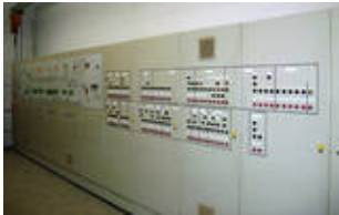
SPS-Steuerungsanlage
